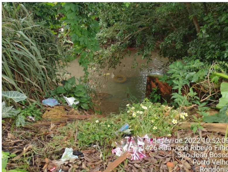
Figura 04 - Canal com despejo de esgoto e lixo.
